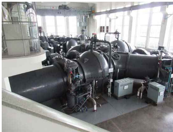
(写真 1 : 手賀排水機場ポンプ室)
