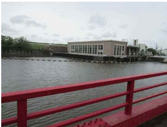
(写真 3 : 手賀排水機場全景)
