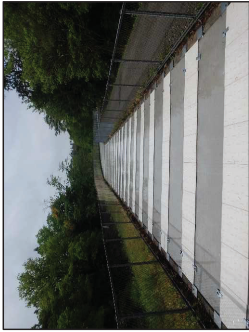
H30 導水幹線水路耐震補強(その7-2)工事 蓋設置完了
