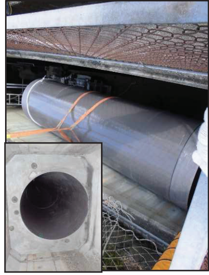
FRP管による鞘管工法
