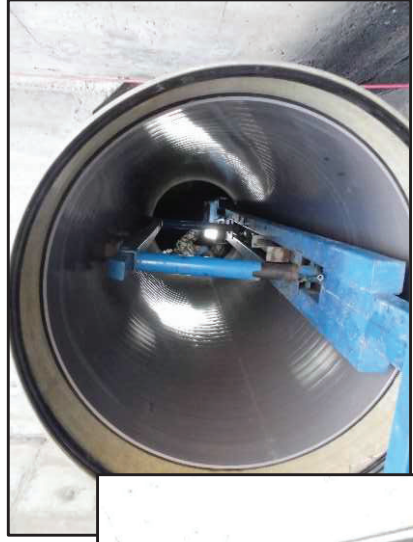
FRPM管設置状況
