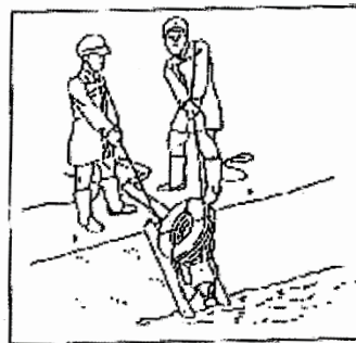
ポンプ投入例
