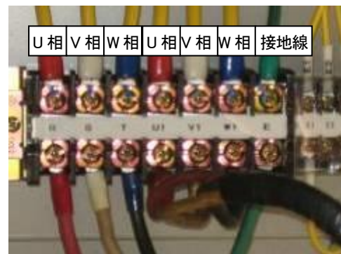
制御盤とキャブタイヤケーブル接続状況
