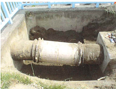
③変位量再計測、障害物との距離確認
