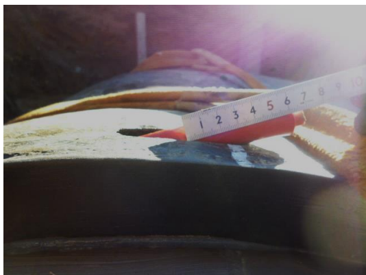
④ワイヤ挿入量の管理 (出代の測定: 130mm以下)
