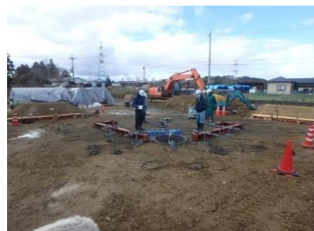
埋戻し後試験状況
