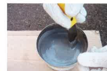
⑦ 反応が始まるので 缶底の隅まで2～3分 しっかり混ぜる。
