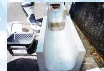
③ 下塗り ミゼロンシーラーU-60を ローラーで塗布。
