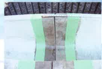
④ 下塗り後 所定の塗り幅で養生テープ を貼る。
