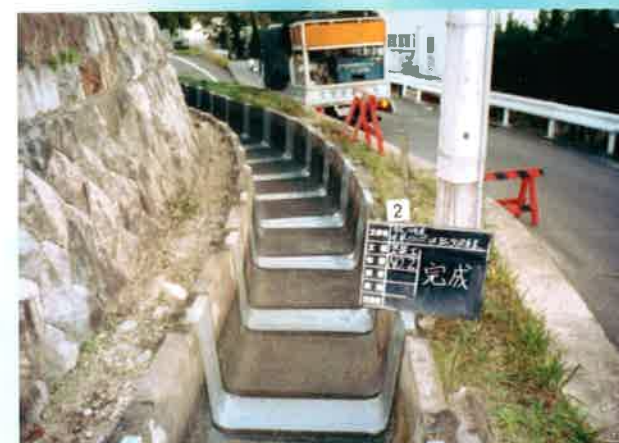
平成10年3月（1998年） 施工当初（長野県大町市内）
