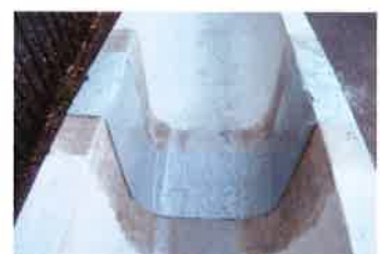
⑫ 完 成 塗料が乾かないうちに 養生テープを剥がす。 膜厚が薄い箇所がないか 確認する。
