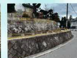
漏水が止まり 路面が乾いています
