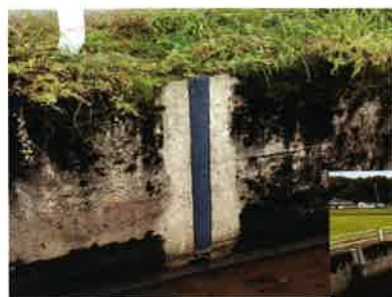
現場打ち水路
