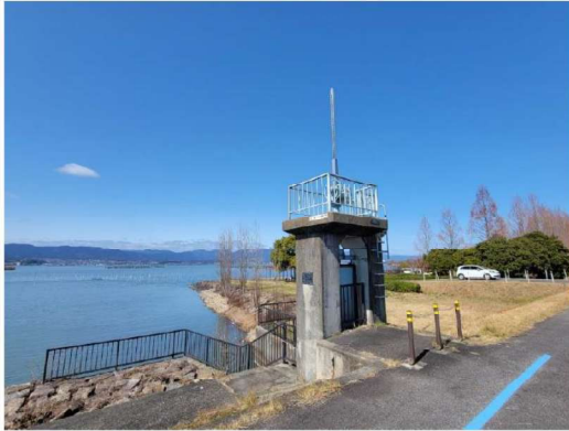
滋賀県琵琶湖：山賀川樋門
