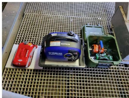
予備電源のために発電機・ガソリンを備蓄
