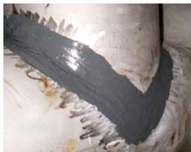
SUS溶接部補修
