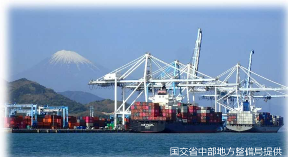
国交省中部地方整備局提供
