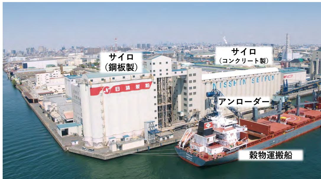
港湾地域の穀物サイロ全景
