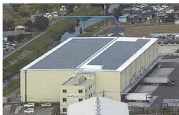
東名厚木ロジスティックセンター
