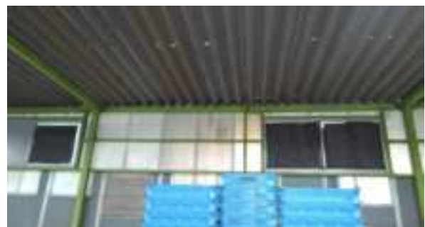
（側壁、屋根の状況）
