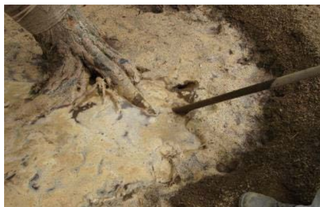
棒等で突き、土を詰める
