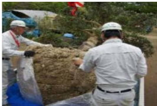
根巻き資材の除去
