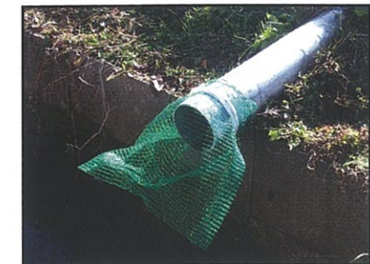
ネットを設置した排水パイプ
