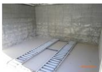
水洗、消毒後、消石灰乳を小屋の内外の壁面、天井、床に塗布する。
