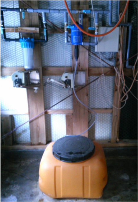
図８－１ 自動投薬配合器使用に関するプロトコル。 （平成27年度のS、W、Y、Z農場（１ロットあたり約10,000羽）で消毒方法を検討し、うちS、Z農場で実際に鶏舎内の飲用水の遊離塩素濃度を検証）
