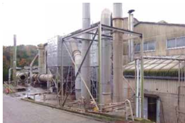
■ 三興株式会社 肥料製造工場外観
