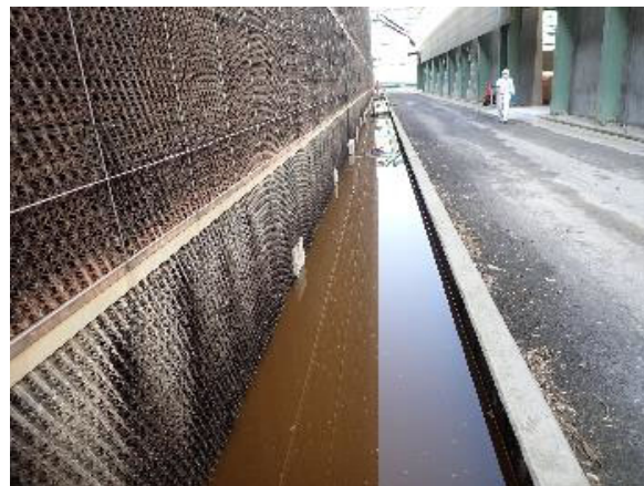
<外気にさらされた貯水槽>
