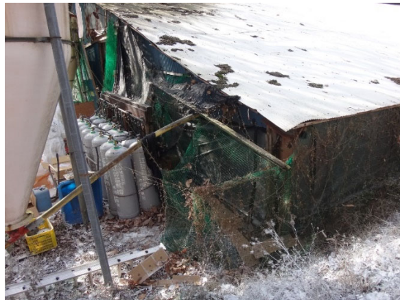
<防鳥ネットの隙間>
