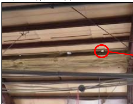
<発生鶏舎の天井>
