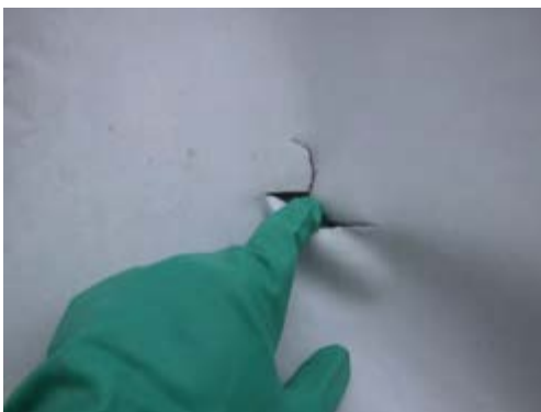
＜発生鶏舎の側面のロールカーテン＞
