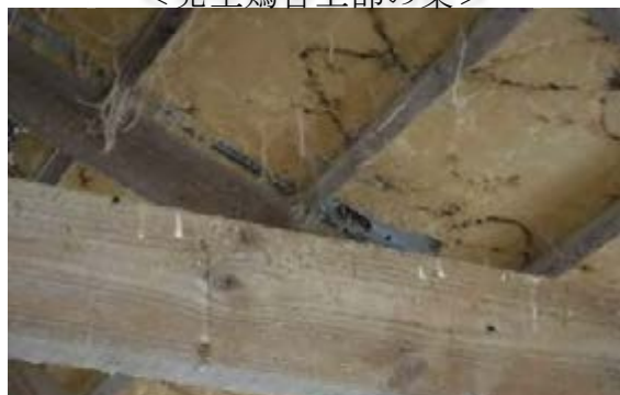
＜発生鶏舎上部の梁＞
