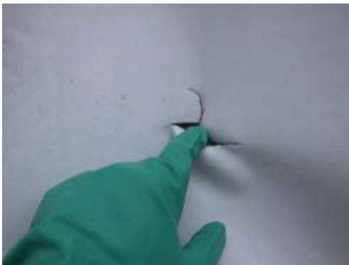
＜発生鶏舎の側面のロールカーテン＞
