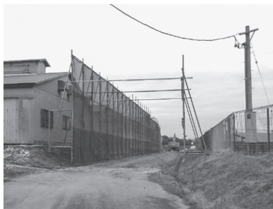
(写真3) 発生農場での防塵ネットの設置
