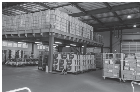
(写真4) 宮城県防疫資材倉庫の備蓄資材の状況
