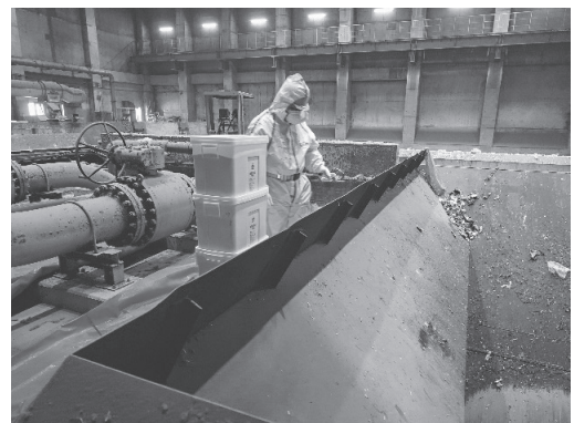
（写真1）焼却作業（ホッパーへの投入）
