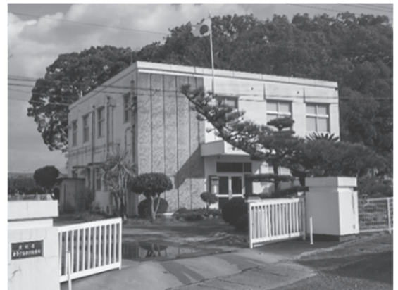
東予家畜保健衛生所外観
