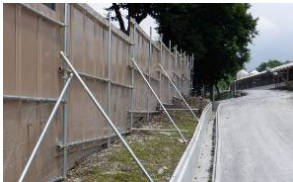
＜野生動物侵入防止壁＞
