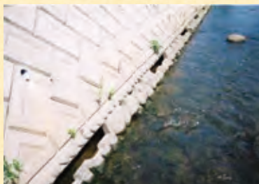
生息場・避難場所となる 魚巢ブロックの設置
