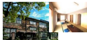
廃校を改修した大規模滞在施設
