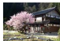
古民家等の改修
