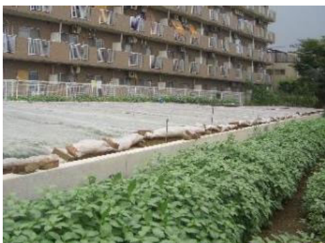
土砂流出対策の土留め
