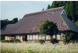
改修予定の古民家
