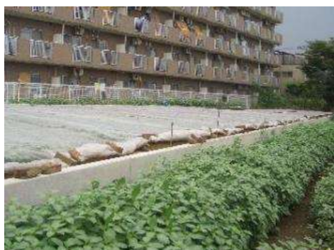
土砂流出対策の土留め
