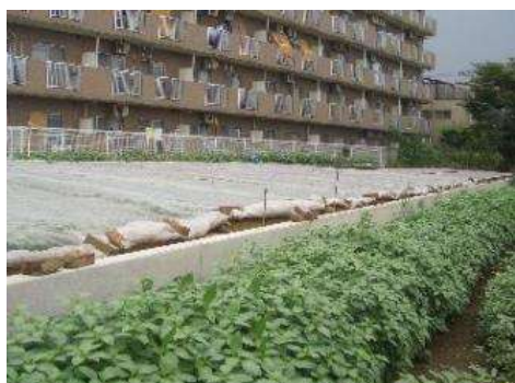
土砂流出対策の土留め
