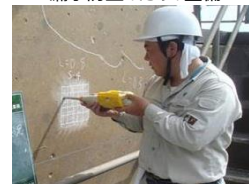
老朽化した施設の機能診断
