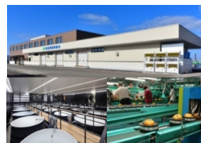
集出荷・貯蔵・加工施設
