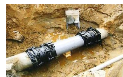
漏水防止のための整備
