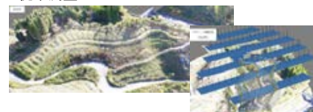
ドローン画像を活用した鳥獣害防止柵の出来形管理
