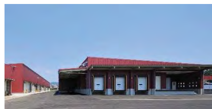
集出荷貯蔵施設
