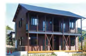
ICTオフィスの新設
