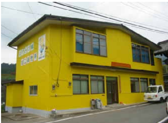
～ 今後の活動拠点となる加工直売施設 ～
