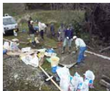
用排水路の改修工事
