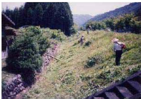
法面の草刈り
