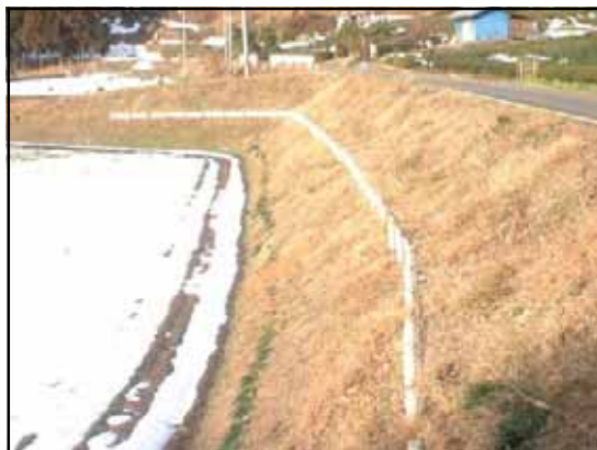
法面中段の足場
