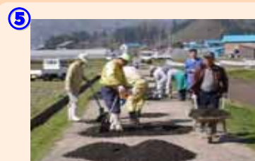
（地域共同による農道の補修）
