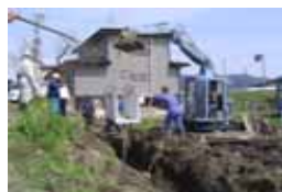
自主施工による水路の布設替え (岩手県小山市地区)
