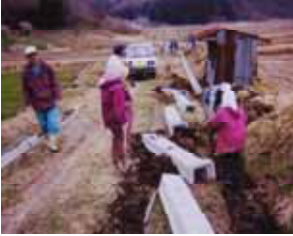
水路敷設工事
