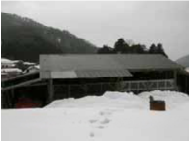
集落の共同作業で設置した格納庫
