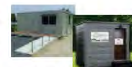
休憩所、トイレの整備
