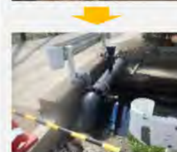
水管橋漏水部の補修
