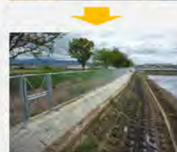
ネットフェンスの更新
