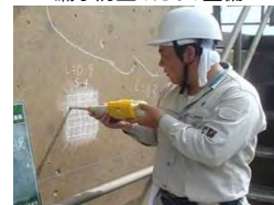
老朽化した施設の機能診断
