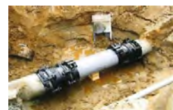
漏水防止のための整備
