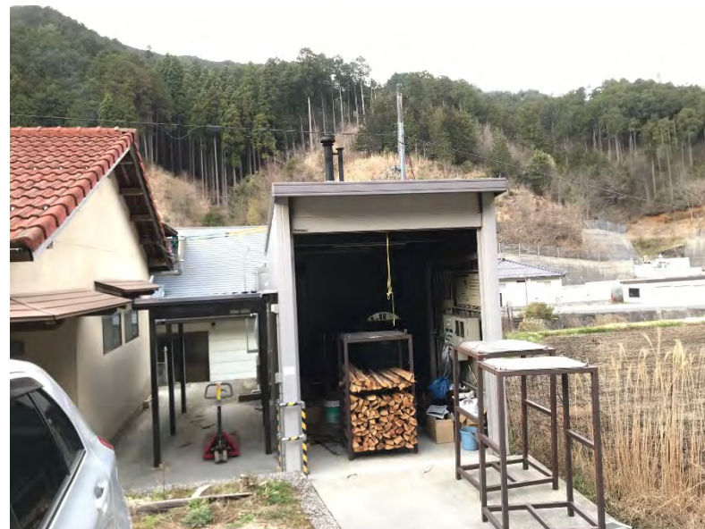
薪ボイラーで沸かす温泉
