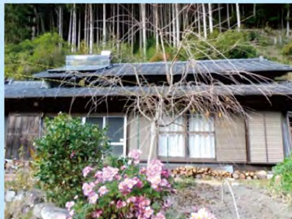
移住者住宅改修補助事業
