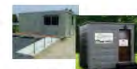
休憩所、トイレの整備
