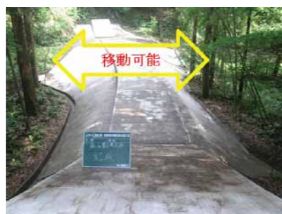
図 6-5 生物の移動に配慮した開水路の施工
