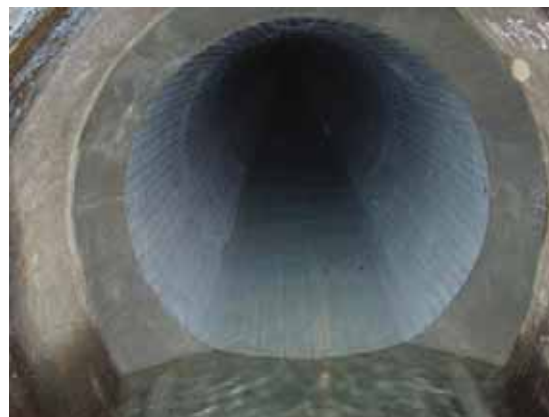
図 7-1 トンネル内巻補強工法の施工状況
