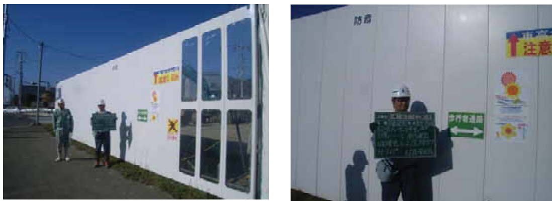
図 6-11 防音壁の設置（福田支線水路柿原 3 号分水工改築）
