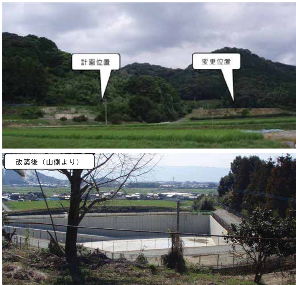
図 6-7 農村景観に配慮した弥永調整水槽
