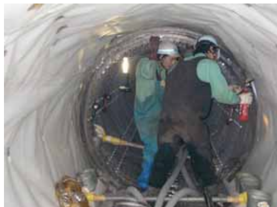
〔 トンネル内巻補強工法完成状況 〕
