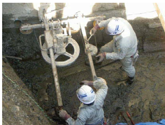
【 ワイヤーソーイング工法 】
