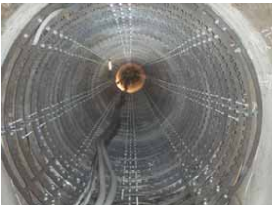
図 7-1 トンネル内巻補強工法の施工状況
