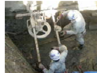
図6-9 低騒音工法を用いた既設構造物の取り壊し
