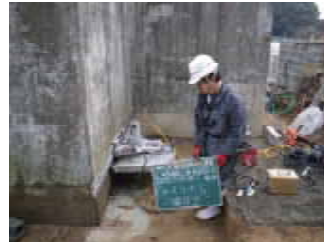
図6-9 低騒音工法を用いた既設構造物の取り壊し
