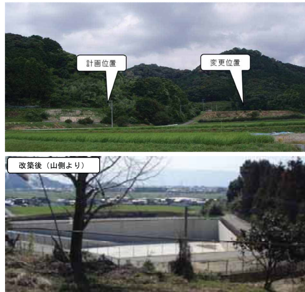
図 6-7 農村景観に配慮した弥永調整水槽
