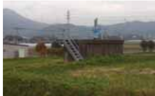
【 夜須支線水路八並分水工 】
