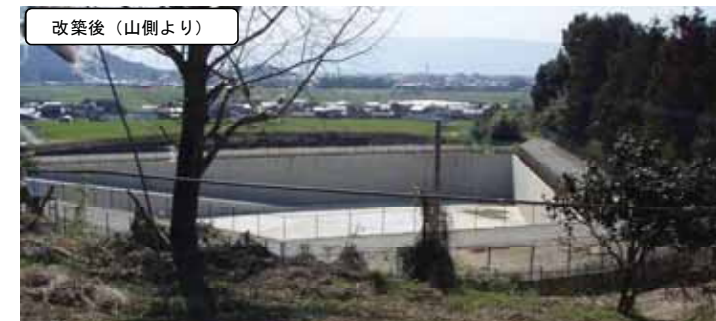
図 6-7 農村景観に配慮した弥永調整水槽
