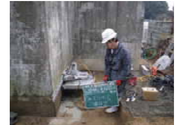
図6-9 低騒音工法を用いた既設構造物の取り壊し
