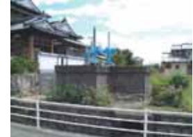
【 福田支線水路堤2号分水工 】
