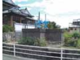
【 福田支線水路堤2号分水工 】
