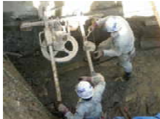
図6-9 低騒音工法を用いた既設構造物の取り壊し
