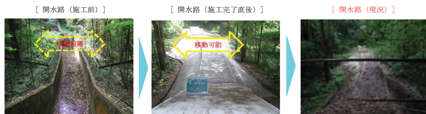
図 6-5 生物の移動に配慮した開水路の施工
