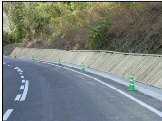
法面保護に間伐材を利用した例
