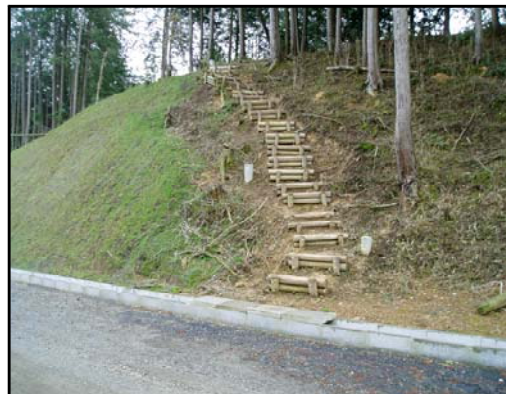
階段工に間伐材を利用した例
