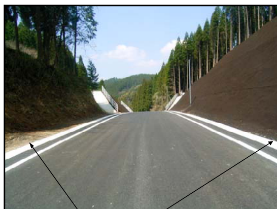
蓋をかけた道路側溝
