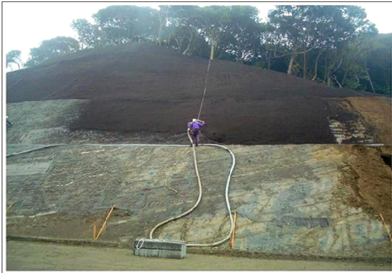
法面保護に現地発生木材チップを利用した例
