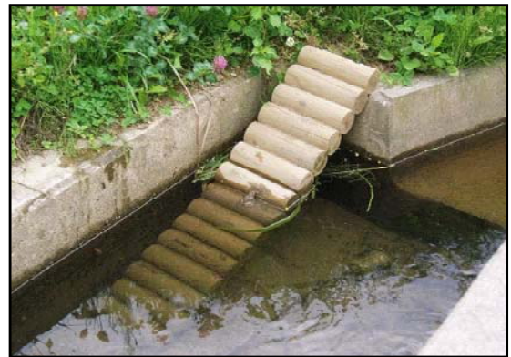
間伐材の小動物脱出スロープの事例
