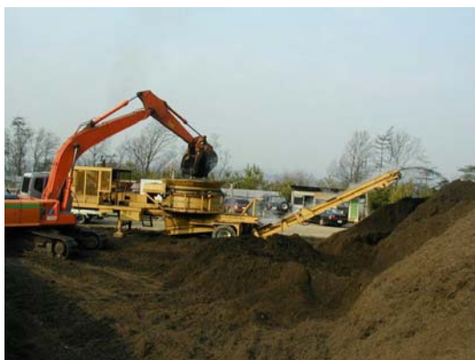
根株破碎状況
