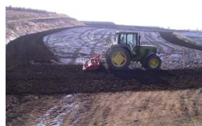
改良材混合攪拌状況
