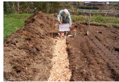
木材加工チップを暗渠排水の被覆材に利用
